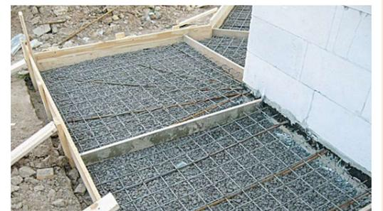
туру, смачивают поверхность и заливают бетоном класса М-100,150. Рабочие переносят бетон вручную до 15-20 метров к месту укладки, замес разравнивают специальным инструментом толщиной слоя до 10 см. После подсыхания бетона выполняются работы по железнению поверхности для упрочнения наружного слоя.
