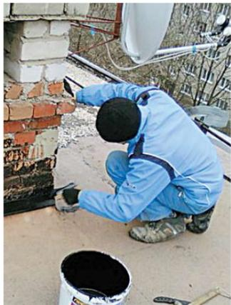
дефекты кровельного ковра, при «помощи» которых вода затекает в квартиры. Выполняются ремонты ливневых водосточков, выходов на кровлю, примыканий и т.д., уборка мусора на кровле. Также обеспечивается составление актов обследования помещений многоквартирных домов.
