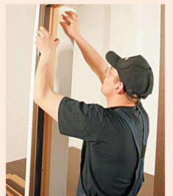
ски коробки с заготовкой нового элемента и укрепляют дверную коробку в необходимых местах. После завершения ремонта убирается рабочее место.
